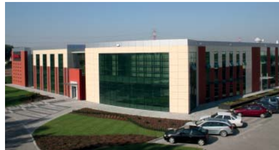
Société Novol à Komorniki (Pologne)
