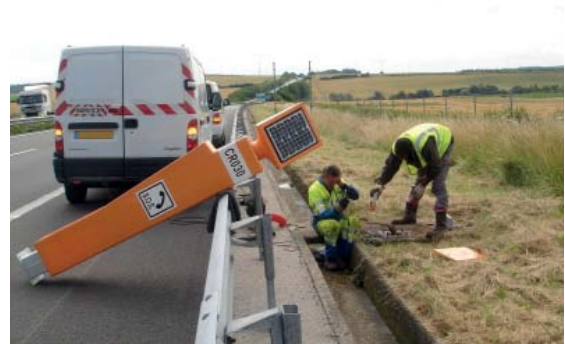
Trabajos de mantenimiento de la autopista
