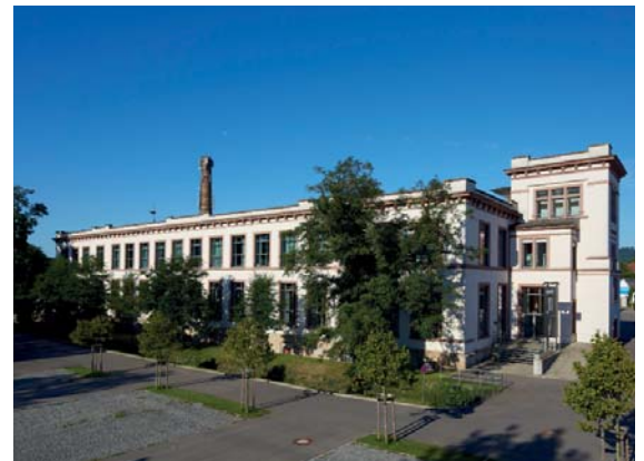
Sede centrale di Ganter Interior a Waldkirch
