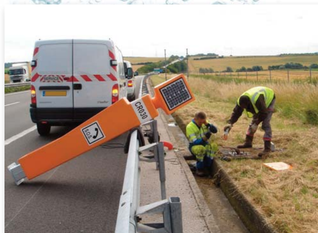
Travaux sur l'autoroute
