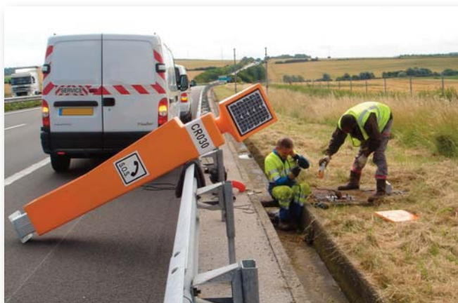
Lavori di manutenzione sull'autostrada
